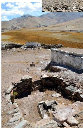
Wir unterstützten deshalb 14 Nomadenfamilien aus GYA bei der Errichtung von Schutzställen im Winterlager, insbesondere auch für Jungtiere. Zum Teil in den Grund eingelassen, zum Teil ebenerdig, wurden steinerne Einfriedungen errichtet, für die besonders gefährdeten Jungtiere geschlossene und
