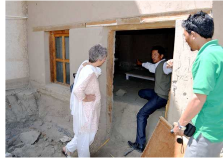
Schlamm bis zur Tischkante im Kompressorraum
